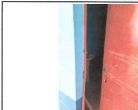
Foto 1: Mantenimiento a puerta metálica existente retiro de óxido, suciedad y pintura deteriorada; incluye cepillado, lijado y aplicación de pintura
