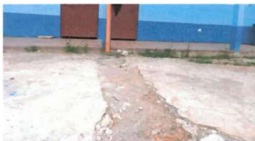
Foto 3: Reparación de losa de concreto para patios, considerando preparación de terreno, armado, nivelación y acabado rustico.
