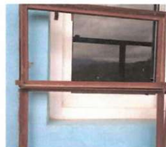
Foto 2: Sustitución de balcones metálicos en mal estado, incluyendo fijaciones, pintura y soldaduras.
